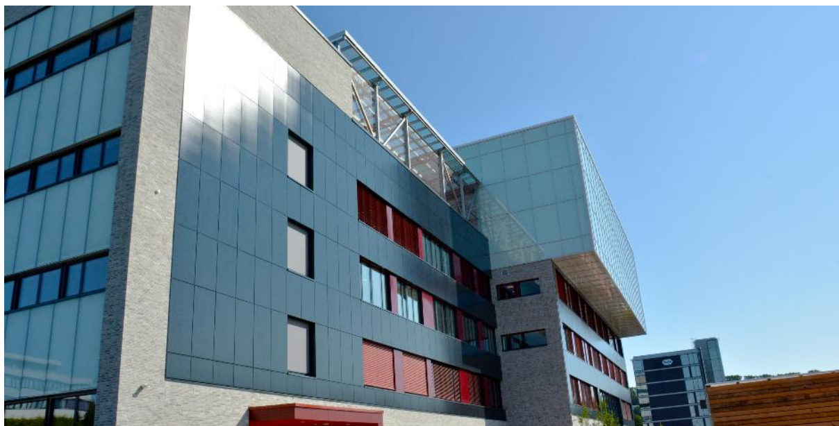
BIPV-solceller på Brynseng skole. Foto: Undervisningsbygg
