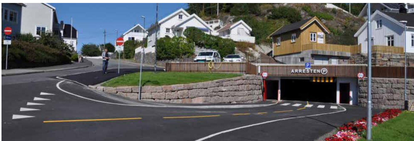
3. Arresten - parkering i fjell. Foto: gat.no
