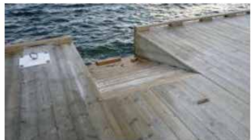
Utsparing/rampe i brygge kan også benyttes til landstigning fra kano. (Skisse og ferdig anlegg Torvhola)
