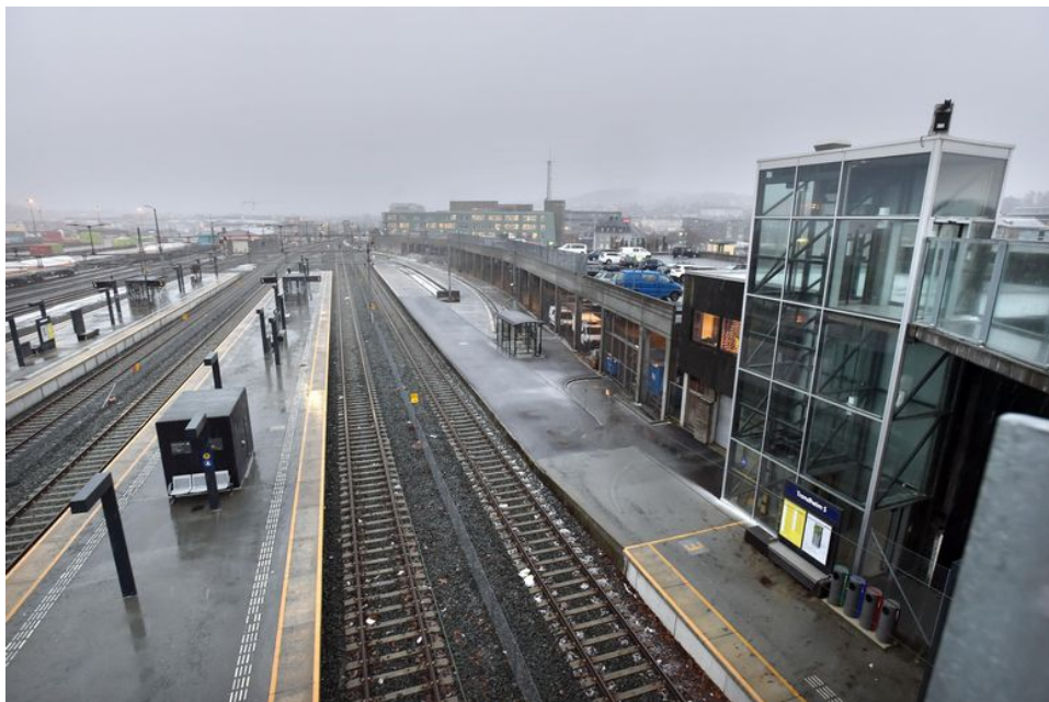
Lokk: Over de fem første sporene legges et lokk. Oppå lokket skal det bygges bl.a. boliger. FOTO: JENS PETTER SØRAA, ADRESSEAVISEN
